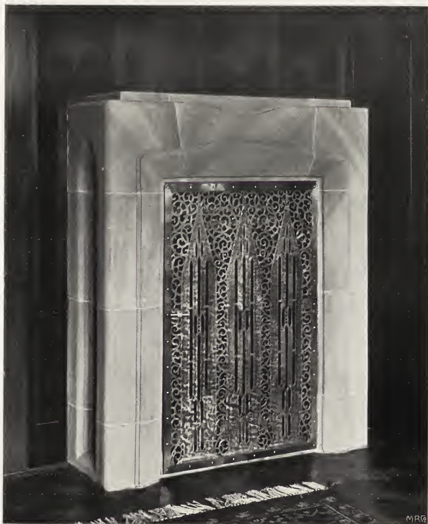
PROF. PAUL HAUSTEIN. Heizkörper-Verkleidung in der Villa Kommerell. Ausführung der Savonnière-Steinarbeit: Bildhauer Fr. Rühle—Stuttgart, der Metallarbeit: Wilh. Heinkel—Stuttgart.
